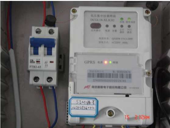
图 5 指示灯显示绿色时,GPRS 信号很强,一般在 -65 db 以上
