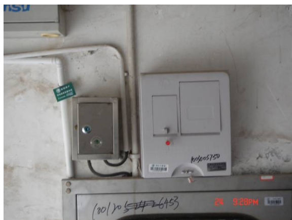
图3 三种不同的表箱和电源集中装在同一楼道口
